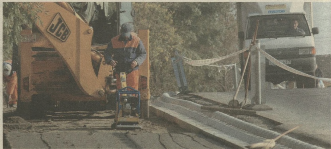
A gyálaréti vasúti átjáróban már épül a biztonságos és korszerű kerékpárút
