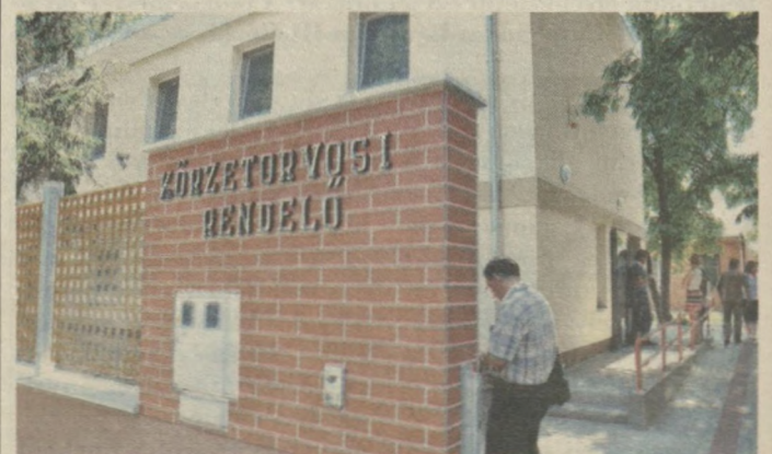
Kívülről is teljesen megfiatalodott az épület.
