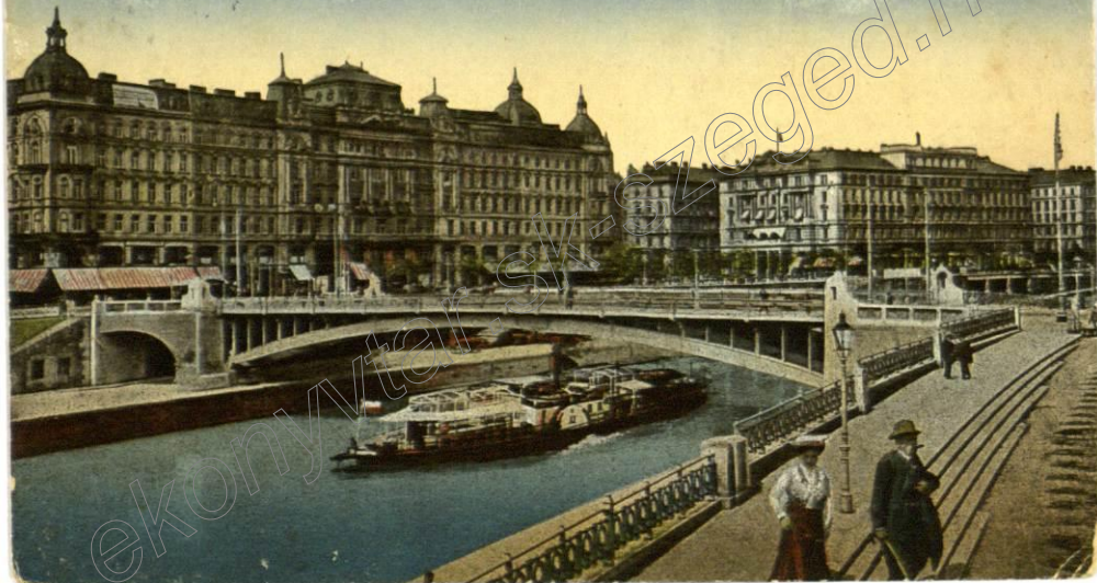
Wien I. Marienbrücke.
